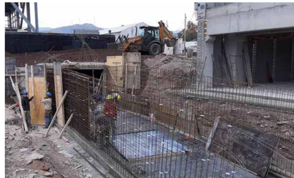
Montaje de paneles cassaforma en celdas de núcleo de detenidos
