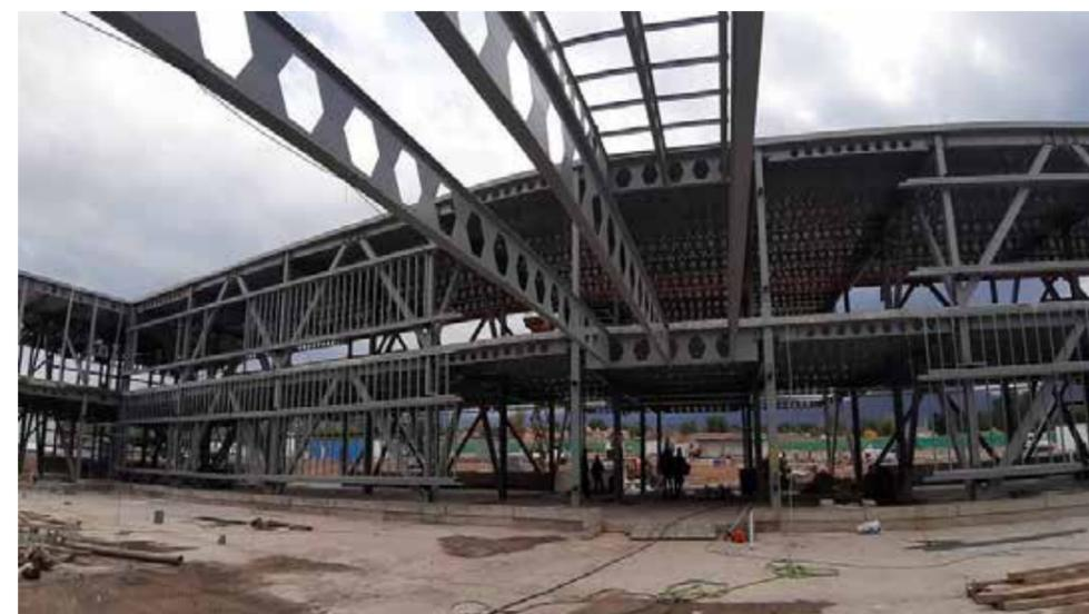
Montaje en patio interior de estructura de soporte para paneles de cierre
