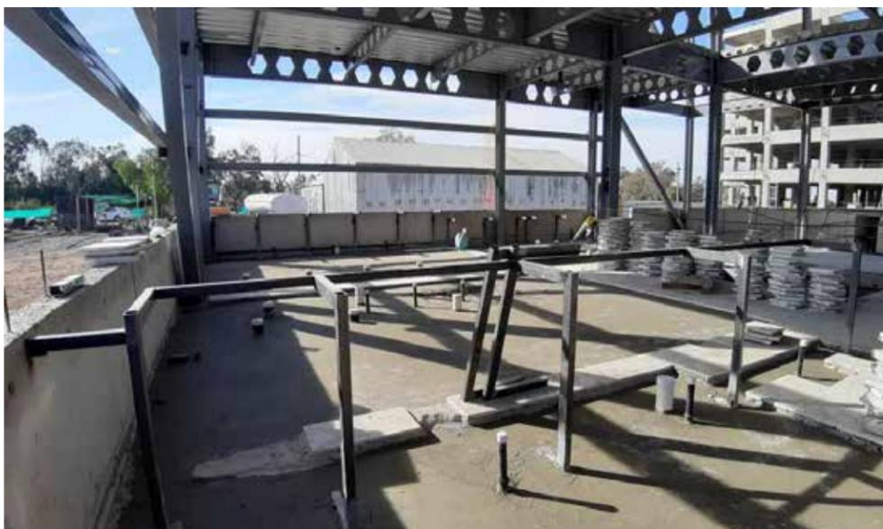
Instalación sanitaria en baños personal y colocación de soportes para instalación de mesadas
