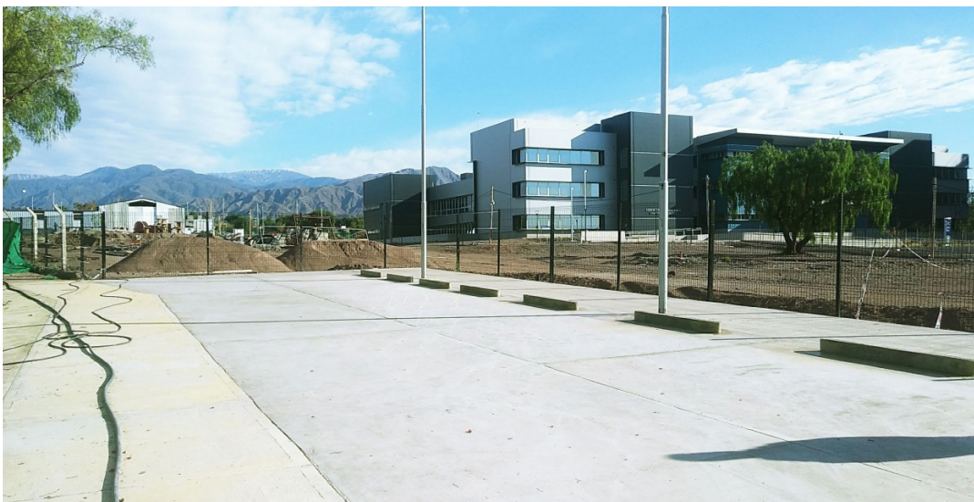
Exterior instalaciones Polo Judicial Penal.
