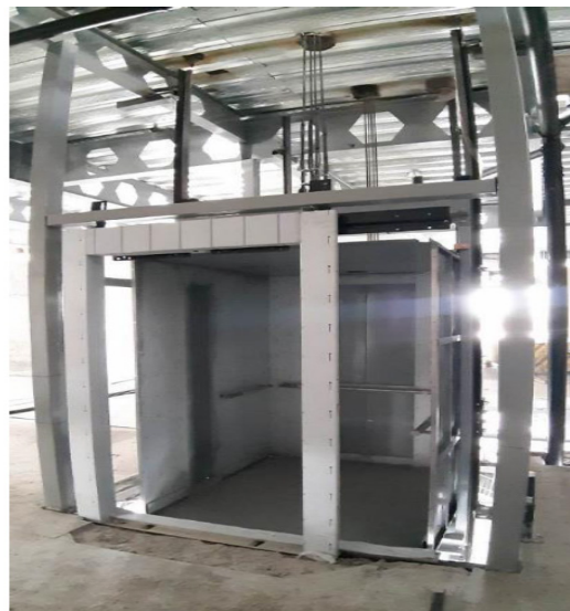
Montaje y prueba de ascensores de detenidos.
