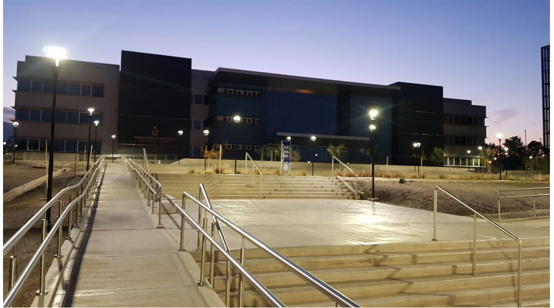
Ingreso principal rampa y escaleras
