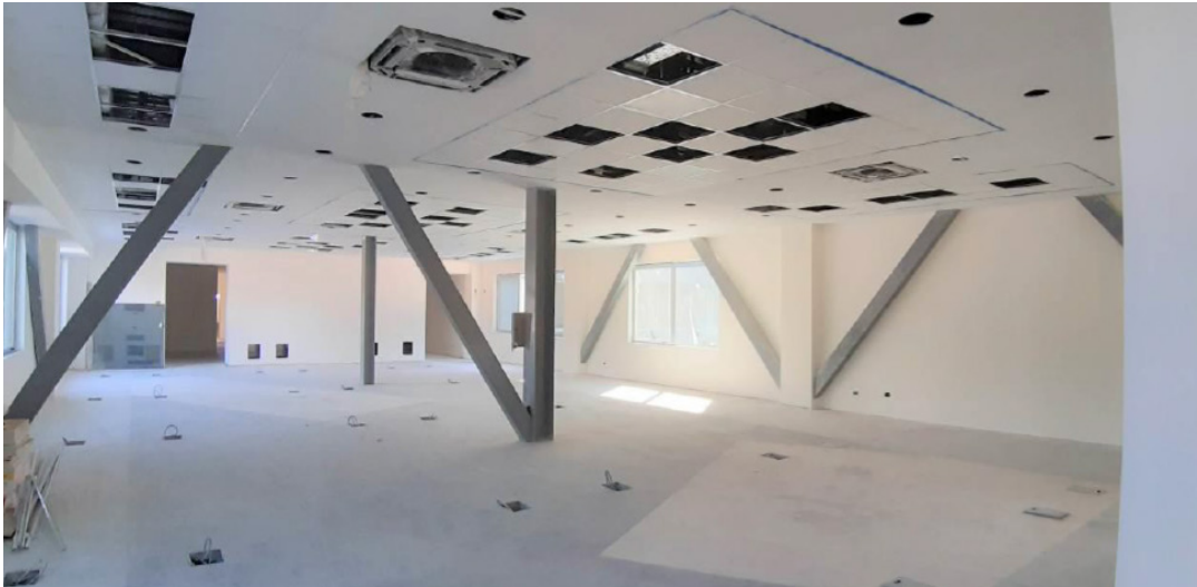
Terminaciones e instalación en Administración P.B.
